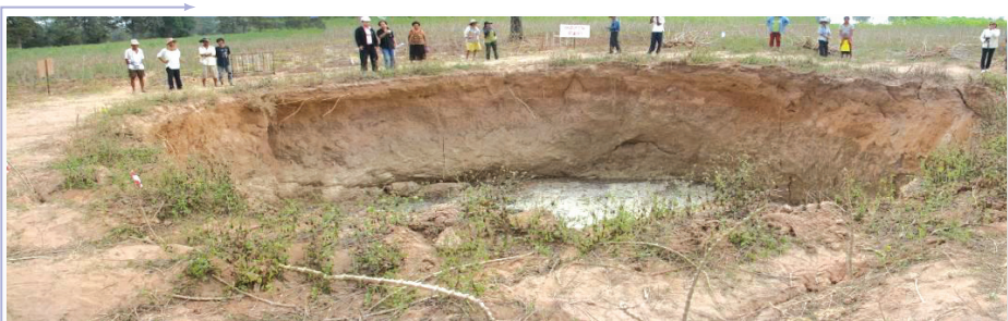
หลุมยุบมีลักษณะเป็นทรงกลม ขนาดเส้นผ่าศูนย์กลาง 10 เมตร ลึก 10 เมตร บ้านหนองราง หมู่ 4 ตำบลคางพลู อำเภอโนนไทย จังหวัดนครราชสีมา
